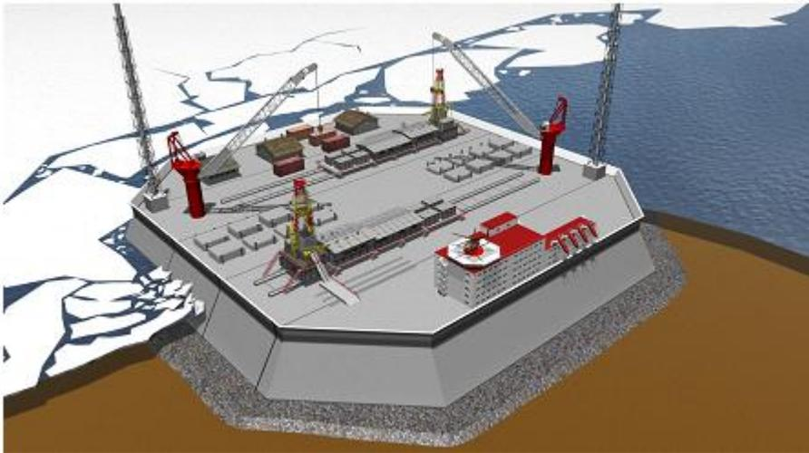
**Область применения:** платформы для бурения и добычи в виде ледостойких островов и барж предназначены для освоения нефтяных и газовых месторождений на мелководных акваториях Российского шельфа.
