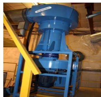
Внешний вид оборудования очистки отходящих газов
